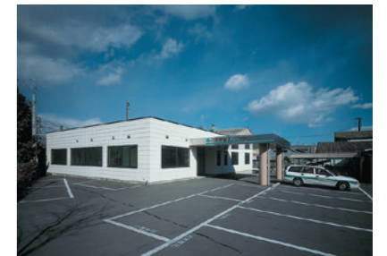
住友林業クレックス 鹿島工場
