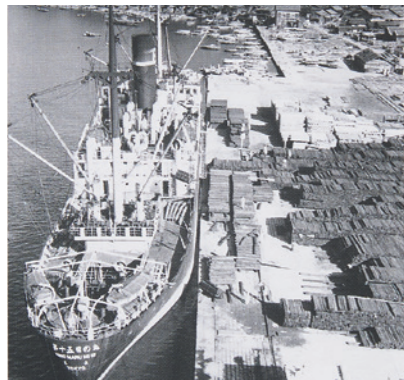
1950年代に活躍した銅製の機帆船、岸壁の木材は鉄道の枕木(日向市細島港) (住友林業50年史)
