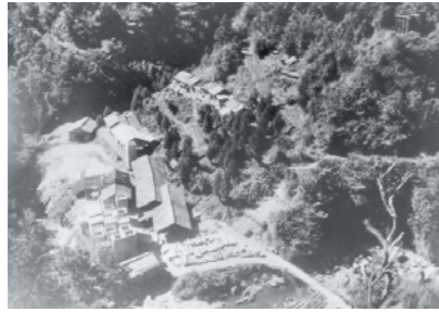
富島支所内の松の内製材所 (冊子「森のちからを、未来のちからに。」)
