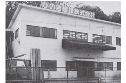
ひのき建設事務所(常緑樹 1983年 13号)
