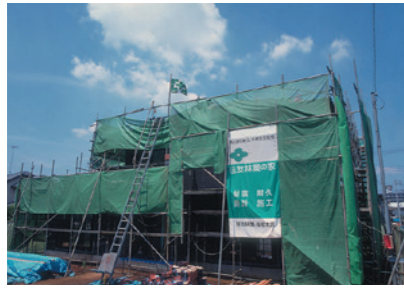
「住友林業の家」施工現場
