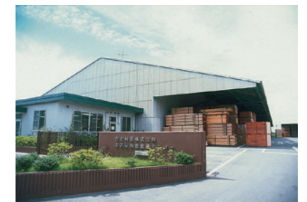
名古屋西港流通センター
