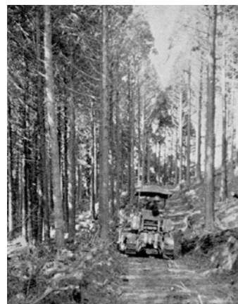
林道建設中のブルドーザー (住友林業月報 1971年 5月)
