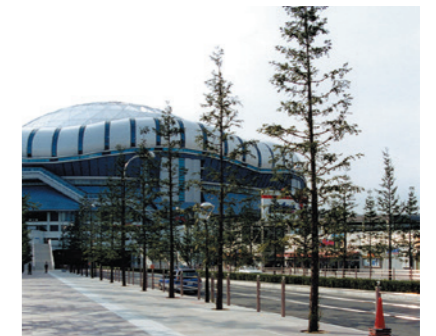
大阪ドーム緑化工事(1997年)
