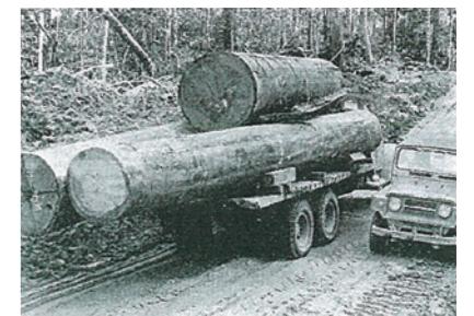
材搬出用の大型トラック(KTI社) (住友林業月報 1971年 7月)
