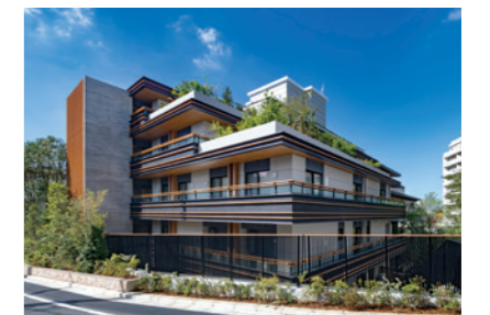
コーナン建設が施工した地上5階建RC造の有料老人ホーム施設「グランフォレスト田園調布」(東京都)
