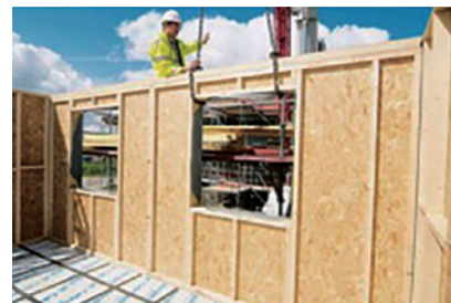
材工一体で提供されるFITP施工現場
