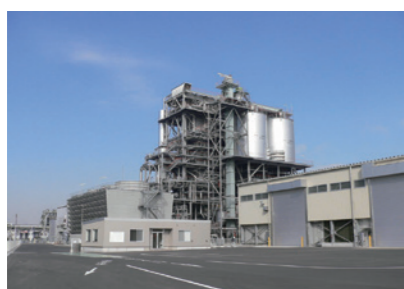
川崎バイオマス発電所
