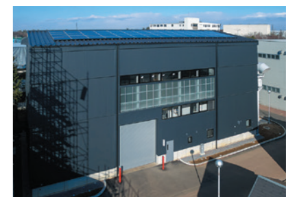
筑波研究所 耐火検証棟(2015年)
