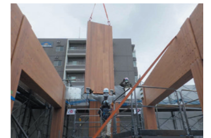
中大規模木造建築 施工現場(熊谷組福井本店)
