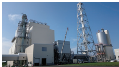
紋別バイオマス発電所 (北海道)
