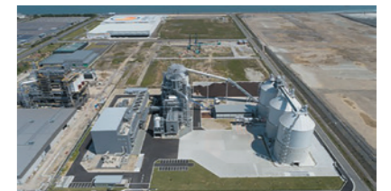
苅田バイオマスエナジー
