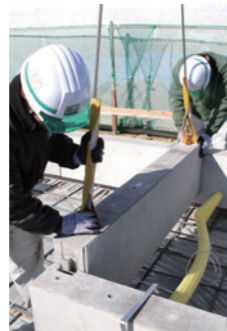
PCa基礎の施工
