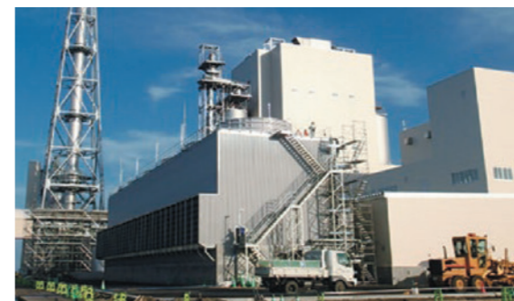
紋別バイオマス発電所
