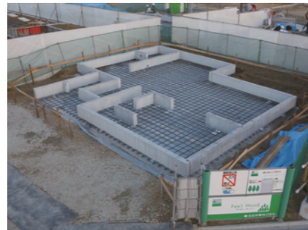
PCa基礎 設置後
