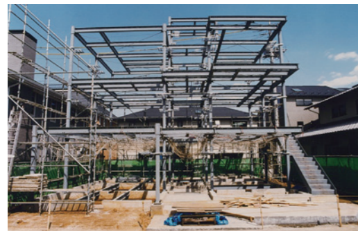
重量鉄骨3階建住宅「夢3階S」構造躯体
