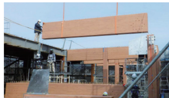
住友林業ホームエンジニアリング 中大規模建築物施工現場
