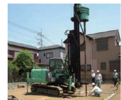
「STパイル工法」のテーパー杭施工(2011年)
