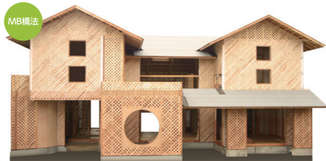
MB構法 構造躯体(2010年頃)
