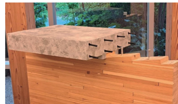
木梁上面を鋸形状にする事でRC床版との一体化と強度を高めた
