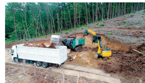
伐採跡地でのチップ化作業(移動式チップパー)
