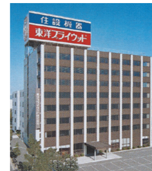
旧東洋プライウッド本社
