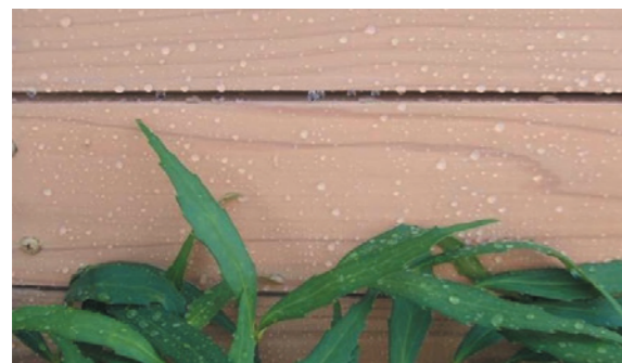
S-100を塗装した外壁：撥水の様子
