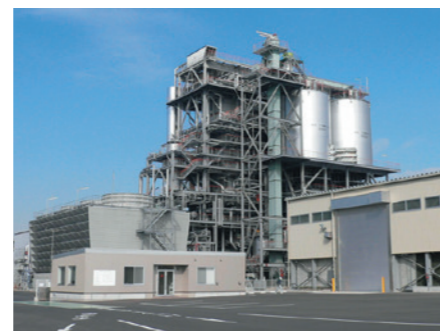
川崎バイオマス発電所
