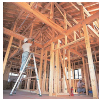
当社施工現場(2000年頃)
