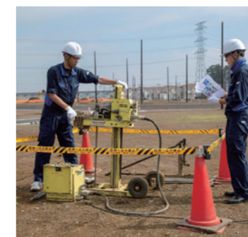
スクリュウエイト貫入試験による地盤判断
