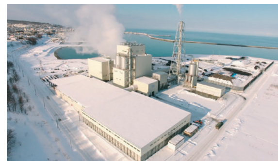
紋別バイオマス発電所 冬景色
