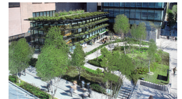
エコアセット事例 三井住友海上火災駿河台ビル(2004年)
