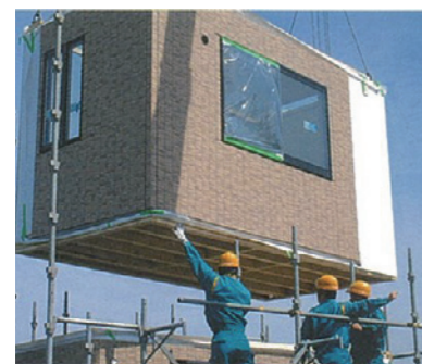
「システム住宅」現場でのユニットの据付
