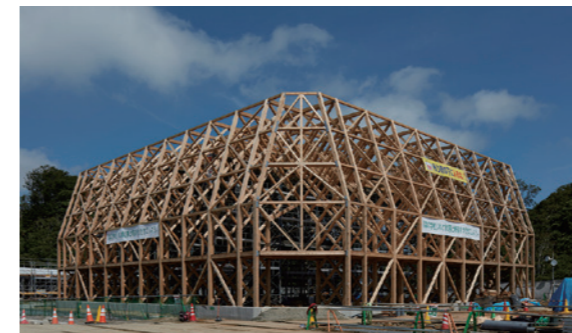
東松島市立宮野森小学校 構造躯体(宮城県)
