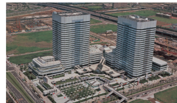
住友林業情報システム(株)本社が入居した幕張テクノガーデンビルB棟(左)(1991年)
