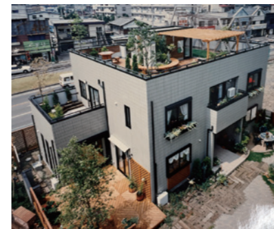
木造軸組工法の工業化「システム住宅」
