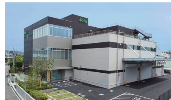
コーナン建設 城東テクノ 開発試験センター(大阪府)
