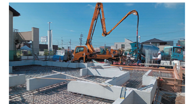
コンクリート基礎打設
