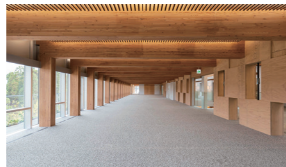
構造用木材が見える仕上げ「あらわし」(筑波研究所新研究棟 2019年)
