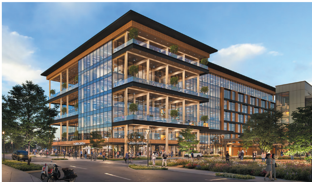
マスティンバー建築の木造7階建オフィスビル(米国)
