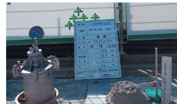
生コンクリート：現場での品質管理 空気量の試験(左)スランプ(柔らかさ)試験(右)
