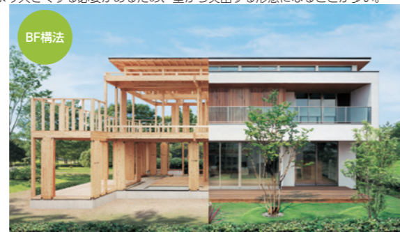
BF構法 構造・完成
