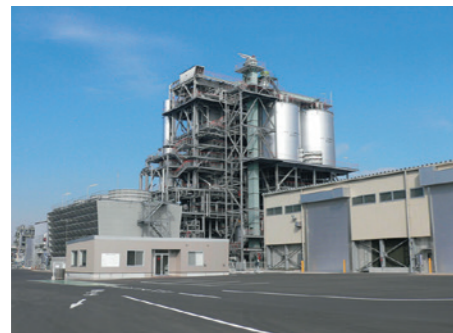
川崎バイオマス発電所
