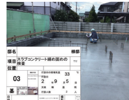
工事検査の記録資料、基礎検査時(2020年)
