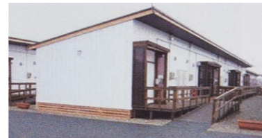
応急仮設住宅(名取市)
