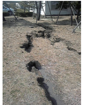
地震による被害 (住友林業クレスト鹿島工場)
