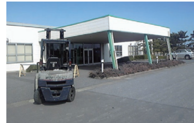
建物被害と液状化(住友林業クレスト鹿島工場)
