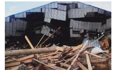
津波で被災した合板工場
