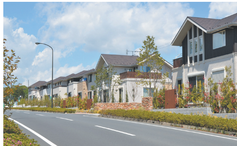
開放的な外構のフォレストガーデン京王堀之内(完成時)
