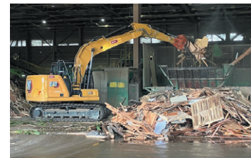
ジャパンバイオエナジーでの建築廃材の活用
