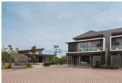
分譲住宅「マカッサル」プロジェクト(インドネシア)
