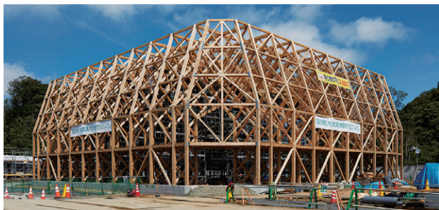
東松島市立宮野森小学校 屋内運動場の構造躯体
