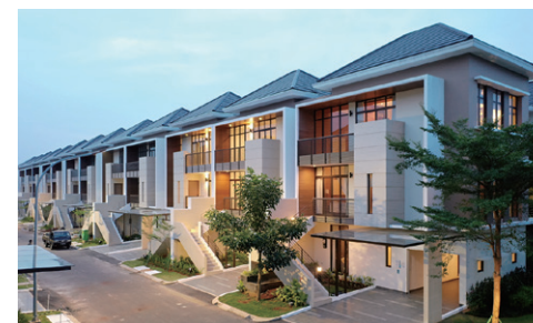
分譲住宅「プカシ」プロジェクト(インドネシア)
