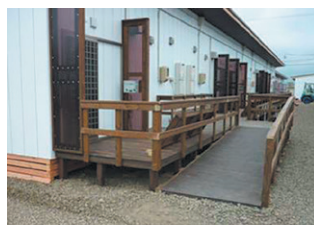
玄関スロープ
