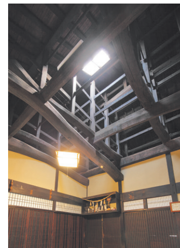
貫と束で組まれた小屋裏とガラス瓦の天窓
