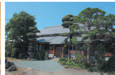
屋根を葺き替えた外観
