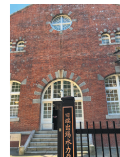
端出場水力発電所
