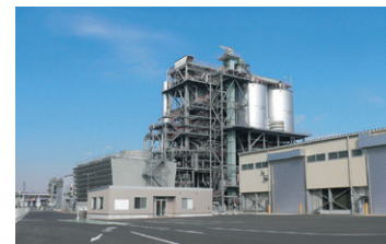
川崎バイオマス発電所
