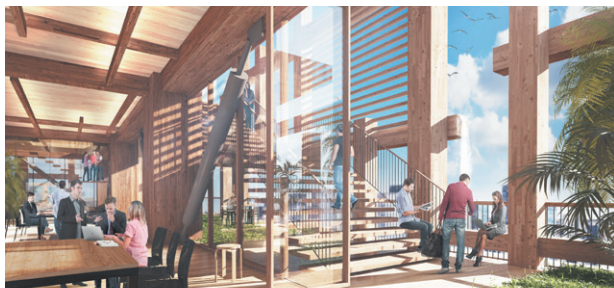
外周部を囲む回廊と鉄骨制震ブレース
