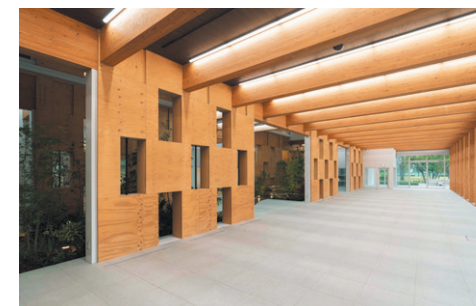
筑波研究所新研究棟にもNPIL社のLVLが使用された
