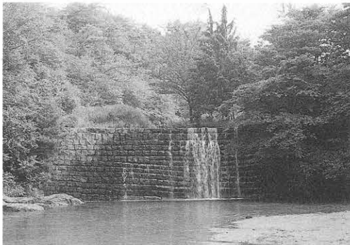
滋賀県草津川上流のオランダ堰堤 デレーケの設計で明治11年の完成と伝えられる
