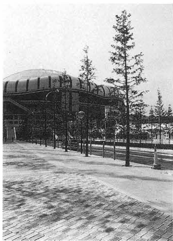
大阪ドーム緑化工事（平成9年）
