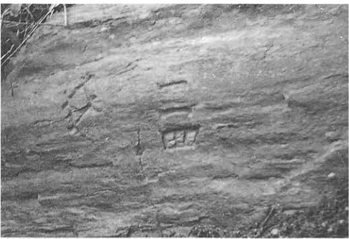
確定した境界に設置する「岩石標」（昭和35年、五良津山事業区）
