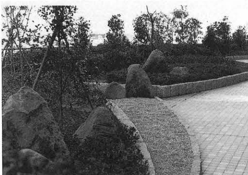
新居浜市庁舎屋上庭園工事(昭和55年)
