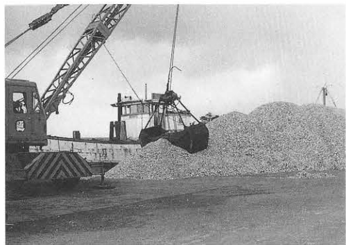
岸壁のチップヤード
