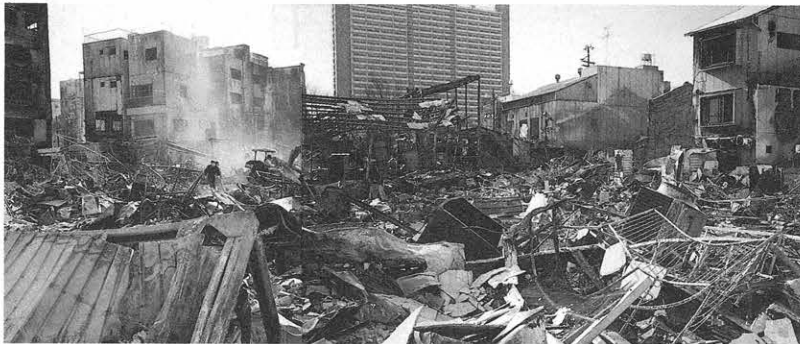
震災後の神戸市長田区の惨状
