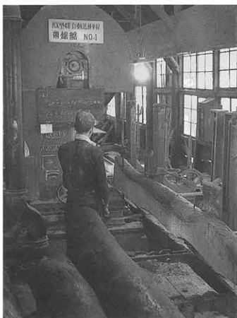
帯鋸による製材(昭和30年ごろの新居浜製材工場)
