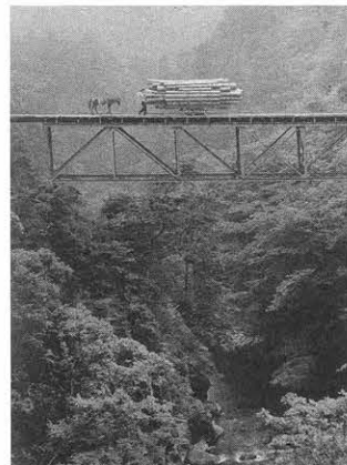
私設軌道による自山材の出材風景、後ろからついてくる馬は主に空トロッコの引き上げる時に使う（昭和20年代）
