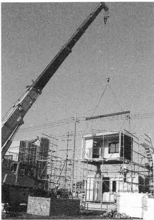
システム住宅（南栗橋分譲・クレーンでの据付け工事）
